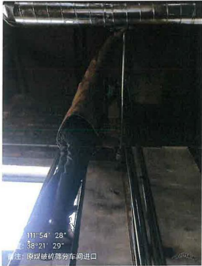
原煤破碎筛分车间布袋除尘器进口
