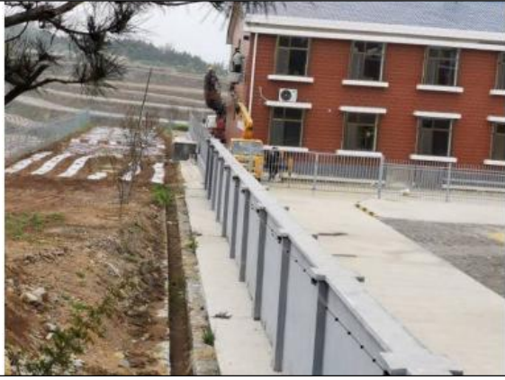
升压站排水沟
