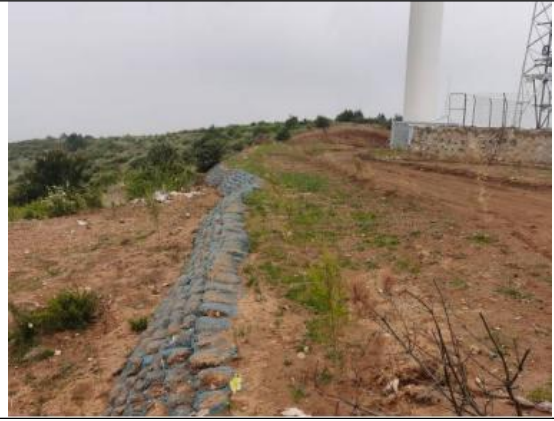
风机箱变植生袋护坡
