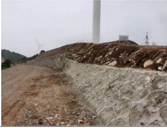
道路工程区浆砌石挡墙
