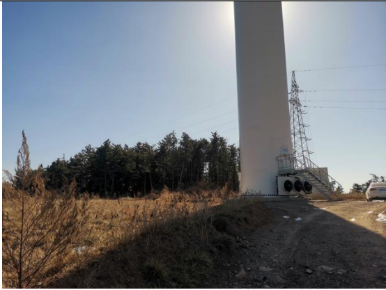
风机箱变植被恢复
