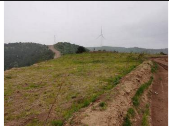
道路工程区植被恢复
