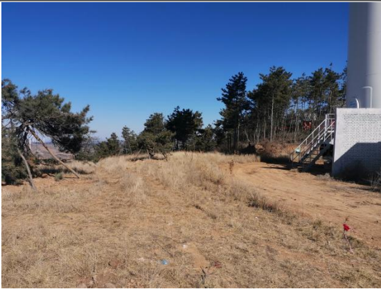
风机箱变植被恢复
