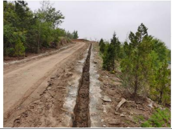
道路工程区浆砌石排水沟
