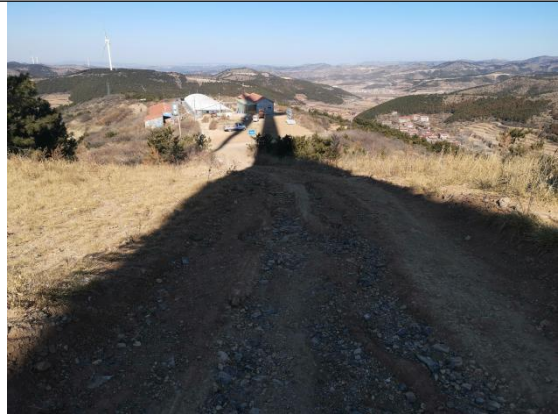
道路工程区植被恢复
