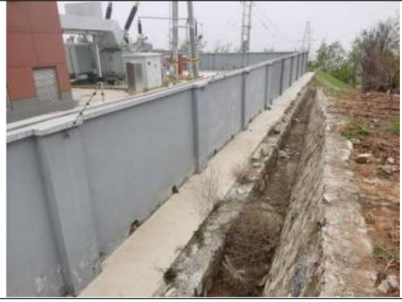
升压站排水沟
