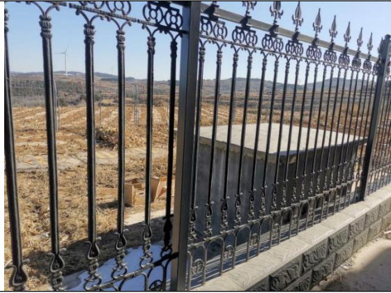
污水地理式一体化处理设施
