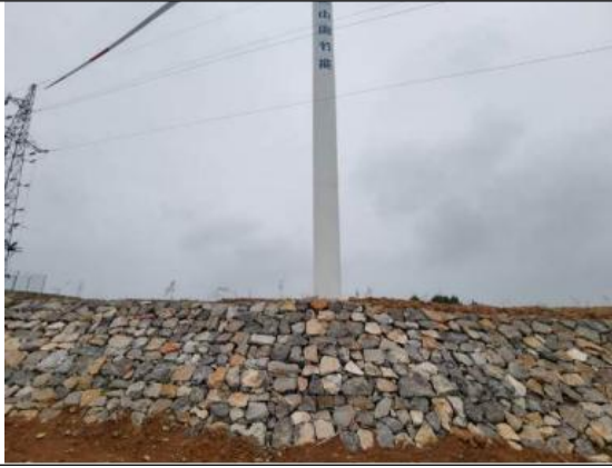
风机箱变干砌石护坡
