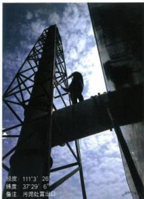
污泥重力浓缩池、污泥均质池、污泥处置中心除臭设备出口 3#
