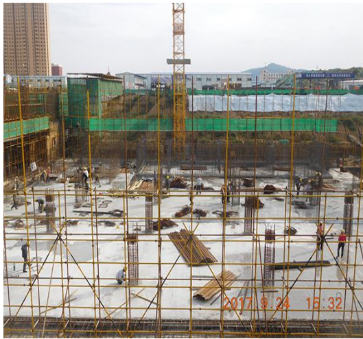
医疗垃圾暂存间砼基础筏板自防水
