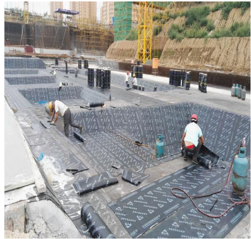
医疗垃圾暂存间基础底 SBS 防水
