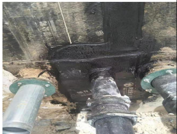
废水管防渗处理
