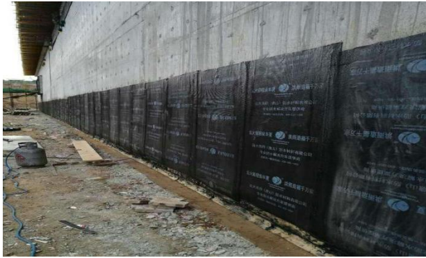
污水处理站外墙防水
